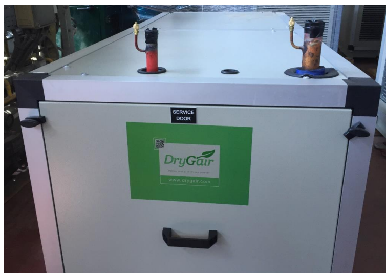
Afbeelding 9-15. Split systeem connectiepunten
