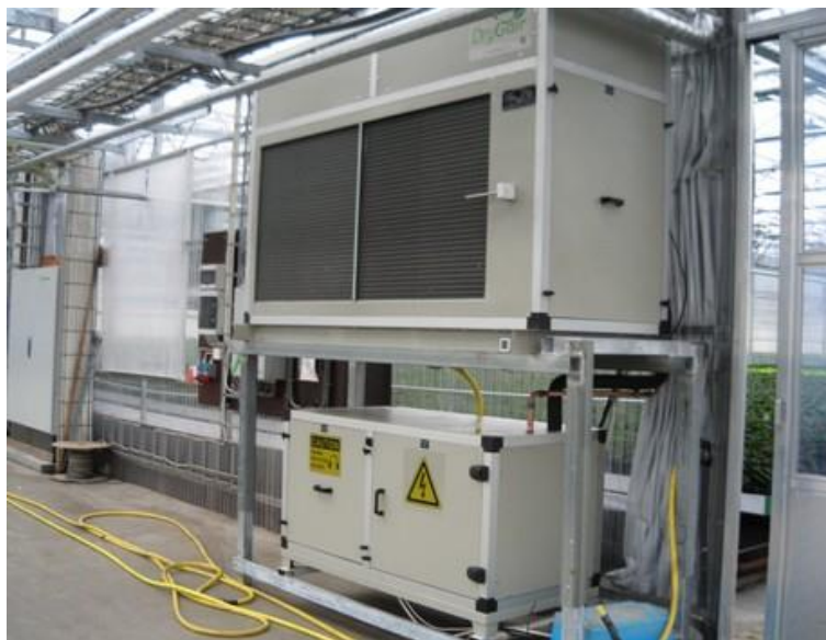
Afbeelding 9-14. Split systeem
